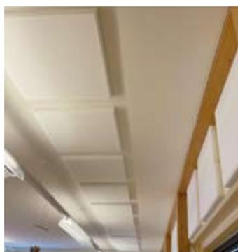
Eine weitere wichtige Anschaffung betraf die Lärmschutzdämmung im Multifunktionsraum. Diese ist ebenfalls bereits montiert und trägt zu einer wesentlich verbesserten Akustik im dortigen Bereich bei.
