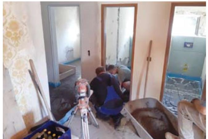
In der nun vergrößerten Garderobe konnte nun der Unterlagsbeton betoniert werden. Die Unterputzinstallation bei der Stiefelwaschanlage wurde abgeschlossen und für die Innenputzarbeiten vorbereitet. Auch sämtliche Schachtverkleidungen sind zwischenzeitlichen fertiggestellt.
