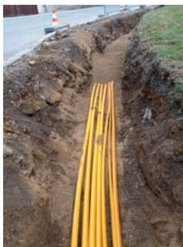
Darin wurden 57 km Röhren verlegt und in diese wurden 183 km Kabel „eingeblassen“. Dank dieser umfangreichen Arbeiten ist gewährleistet, dass alle 543 angemeldeten Haushalte auch tatsächlich an das Glasfasernetz angeschlossen werden können.
