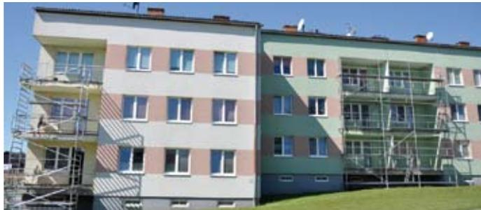
Die Betonsanierung inklusive Gerüstbeistellung, Stemmarbeiten, Abtrag von Fliesenbeträgen, Betonerneuerung, Grundierung, Beschichtung und Versiegelung mit Acryl wurden von der Firma SPARTA Bautenschutz GmbH aus Leobersdorf durchgeführt. Für die Demontage und Montage neuer Alu-Verblendungsfelder wurde die Fa. Manfred Zeilinger aus Allentsteig beauftragt. Die Instandsetzung der Geländerkonstruktion mit Abschleifen, Grundieren und Streichen erledigte die Fa. Josef Mayerhofer aus Zwettl.
