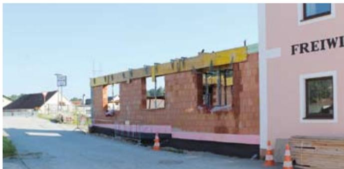
So wurden die Stahlträger bereits eingebaut und die darunterliegenden Mauern abgebrochen. Man kann sich schon daran gewöhnen, dass das neue Feuerwehrhaus wesentlich größer aussieht. Ende Juni wurde die Decke über dem Erdgeschoss betoniert und Anfang Juli wurde bereits mit dem Mauerwerk im 1. Obergeschoss begonnen.
