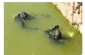
Dazu ebenfalls beigetragen hat die in diesem Zusammenhang durchgeführte Säuberung des Tosbeckens am Fuße des Teichdamms von Verunreinigungen und Ablagerungen. Weiters wurde der Ablasschieber beim Überlauf repariert.
