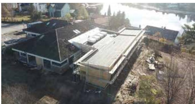
Momentan werden die Ziegelmauern zwischen den Betonsäulen abgerissen und durch Holzriegelwände ersetzt. Des Weiteren wird das Gebäude komplett entkernt und für den Fenster- und Außentüreineinbau, welcher noch vor Weihnachten stattfinden soll, vorbereitet.
