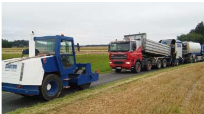
Der Katzenschacherlweg wurde dabei auf der Gesamtlänge von 1,2 Kilometern mittels doppelter Oberflächenbehandlung in voller Breite saniert. Dabei wurde Bitumenemulsion aufgespritzt bei gleichzeitigem Absplitten mit Edelkantkorn. Danach wurde das Material in mehreren Walzgängen verdichtet.
